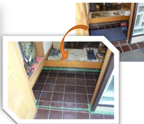
工事 滑り止め加工
