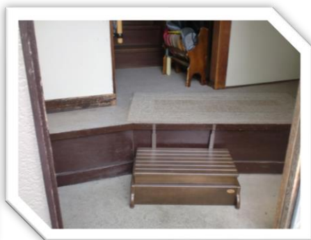
工事 踏み台設置
