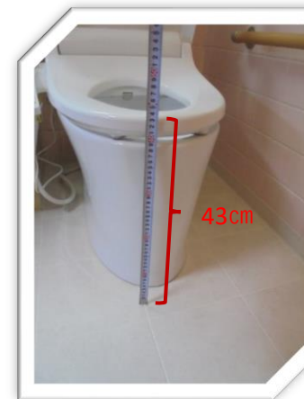
工事 補高便座での矯正が 困難なケースでは、 便器の交換による 便器の高さ変更
