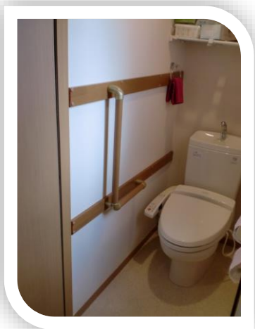
工事 壁面に手すり設置
